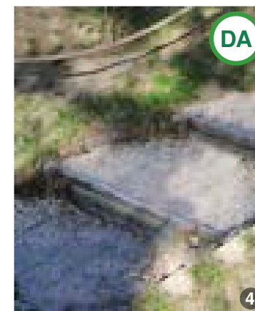
AȘA DA: Scări exterioare cu trepte din piatră și contratrepte din lemn rotund despicaț care se pretează pentru amenajări exterioare.
