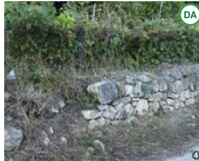
AȘA DA: În zonele cu acces facil la carierele de piatră sau la albiile râurilor, s-a folosit preponderent piatră pentru zidurile clădirilor și a zidurilor de sprijin.
