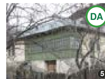
AȘA DA: Prispa poate fi închisă cu o suprafață vitrată dar sub formă de geamlâc, adică folosind tâmplărie de lemn cu goluri mici de maxim 25 x 35 cm.
