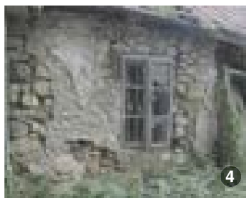
Zidărie din piatră.
