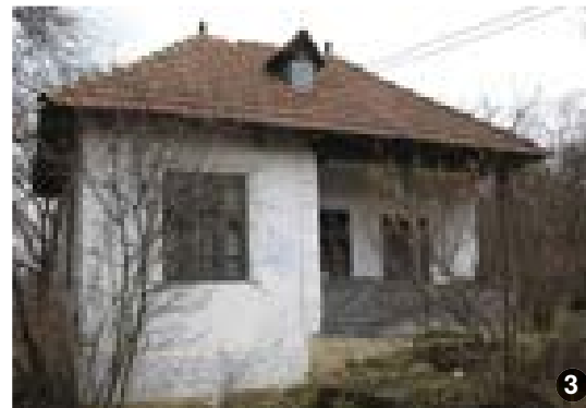
Elementele regulatoare care creează liniile principale ale fațadelor sunt determinate de linia de coamă, linia de streșină, prispă, temelie.
