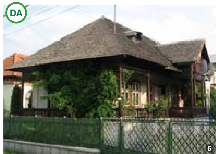
AȘA DA: Casă acoperită cu șindrilă tradițională.
