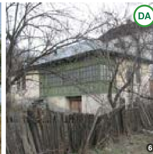
ASA DA: Exemple de închidere a prispei de dimensiuni mai mari, pe toată lungimea acesteia. Proporția și dimensiunile ochiurilor de geam păstrează armonia generală a clădirii.
