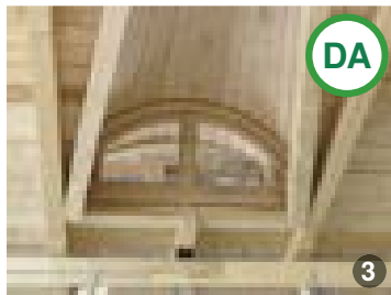
AȘA DA: Amenajarea unor goluri în planul acoperișului aduce cele mai puține modificări volumetriei acestuia.
