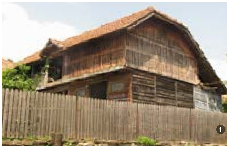
Anexă construită din lemn, al cărei volum poate cuprinde spații utile atât unei locuințe cât și unor funcțiuni complexe, cum ar fi pensiuni. Grijă cu care este prelucrat lemnul o încadrează în categoria exemplelor de urmat în realizarea închiderilor exterioare.
