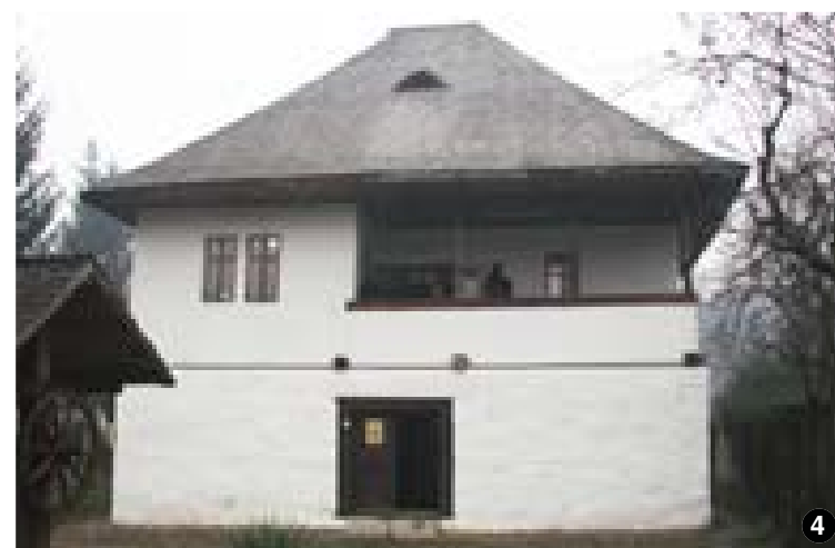
AȘA DA: Prispa se poate desfășura pe o latură întreagă (menționăm că latura trebuie să fie cea lungă) sau prispa poate fi parțială (pe două treimi din latură).
