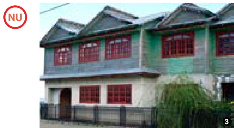
AȘA NU: Forma acoperișului intră în totală contradicție cu noțiunea de încăldare în specific local. Pe lângă asta clădirea prezintă și alte neconcordanțe: volum masiv, distanță prea mică până la limita de proprietate în comparație cu volumul, finisaje, gaturi, tipuri de ferestre necorespunzătoare.
