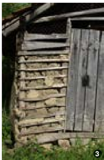
Detaliu schelet din pari de lemn înfipti în pământ cu șipci și umplutură de pământ.
