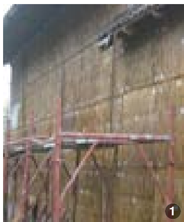
AȘA DA: Exemple de pereți plăcați cu panouri termoizolante de stuf.
