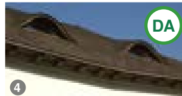
AȘA DA: Micile lucarne amenajate în mansarda unei clădiri pot aduce suficientă lumină pentru spații precum dormitoare, băi etc. Acest tip de lucarnă poate fi folosit cu condiția ca dimensiunea lor să rămână în limita valorilor decente.
