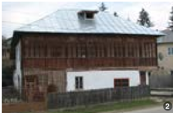
Elementele regulatoare care creează liniile principale ale fațadelor sunt determinate de linia de coamă, linia de streșină, prispă, temelie.
