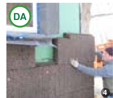
AȘA DA: Plăci izolatoare din plută expandată
