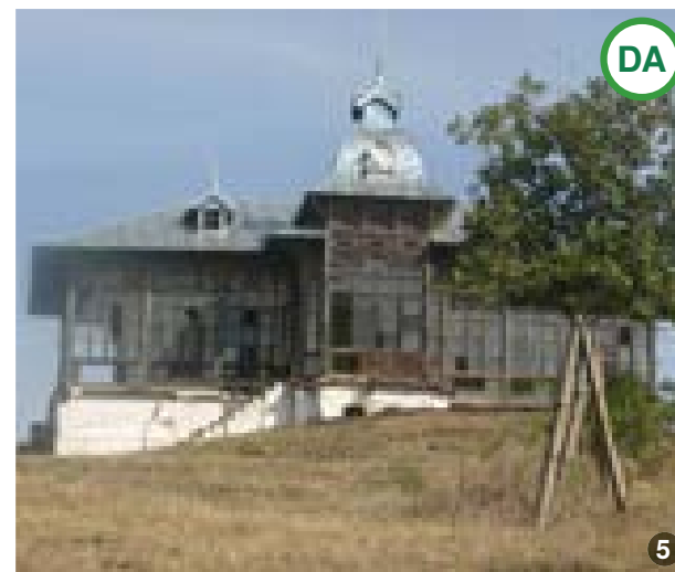
ASA DA: Exemplu de închidere a spațiului unei prispe de dimensiuni mai mari. Acest model de împărțire a foliilor de geam este recomandat pentru scara firească pe care o creează chiar și atunci când este vorba de lungimi mari.
